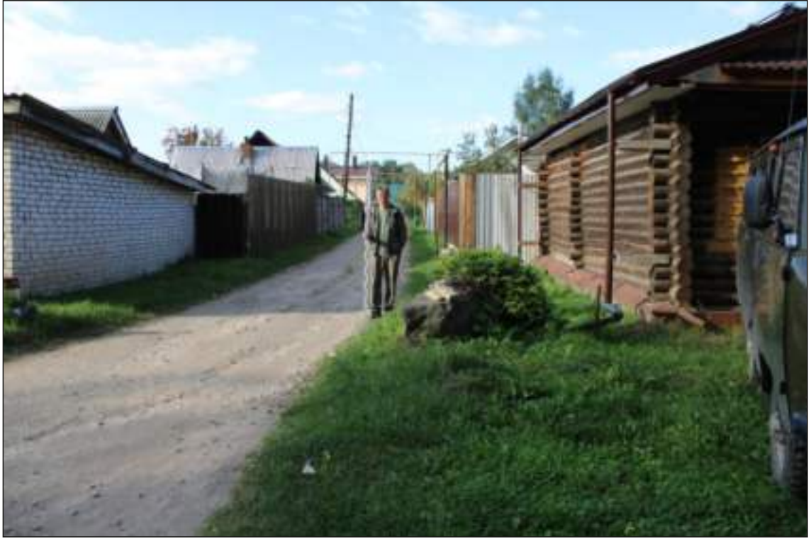
Илл. 21. Фотофиксация трассы проектируемого объекта «Газопровод-ввод к жилому дому по адресу: Нижегородская область, Городецкий район, г. Городец, ул. 9 Января, д. 21». Точка фотофиксации 2. Вид на участок трассы проектируемого газопровода, в пределах которого он будет прокладываться закрытым способом (проколом/продавливанием). Фото с ЮЮВ
