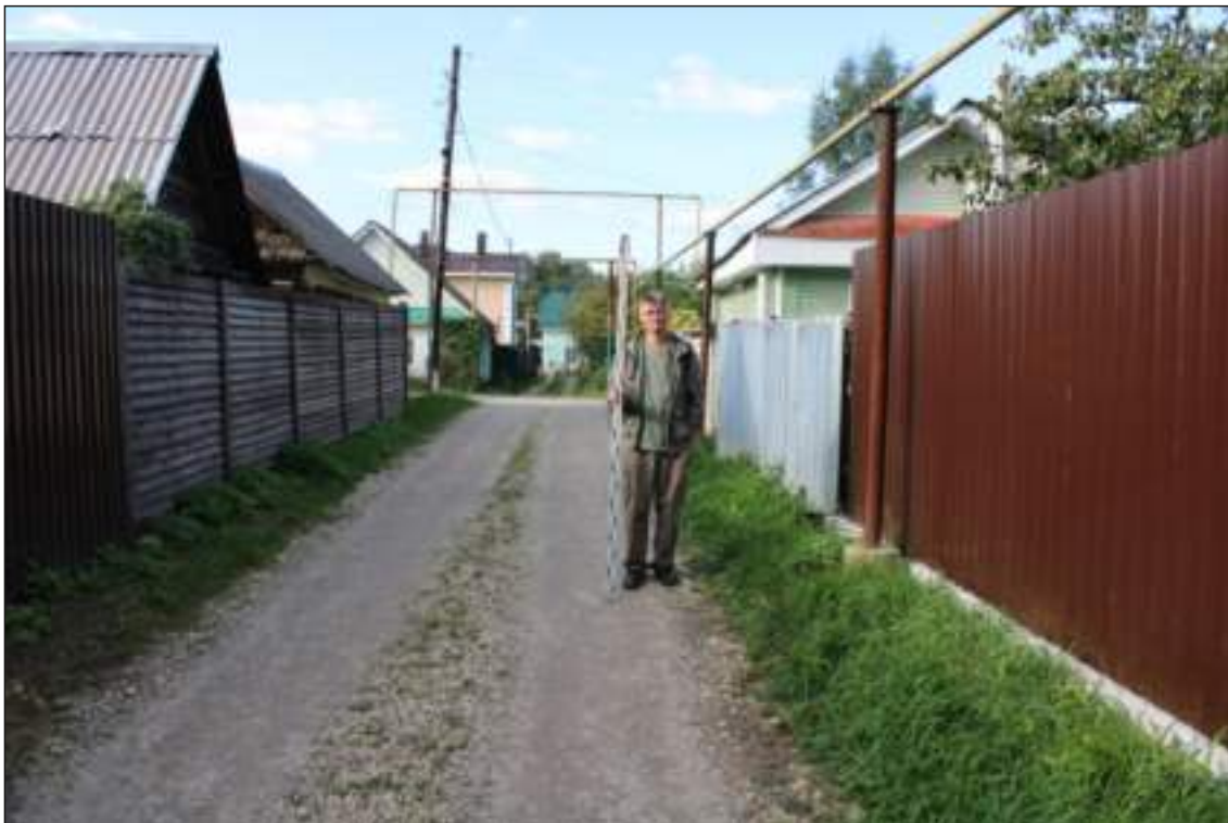
Илл. 19. Фотофиксация трассы проектируемого объекта «Газопровод-ввод к жилому дому по адресу: Нижегородская область, Городецкий район, г. Городец, ул. 9 Января, д. 21». Точка фотофиксации 1. Вид на точку врезки проектируемого газопровода в существующий газопровод. Фото с ЮЮВ
