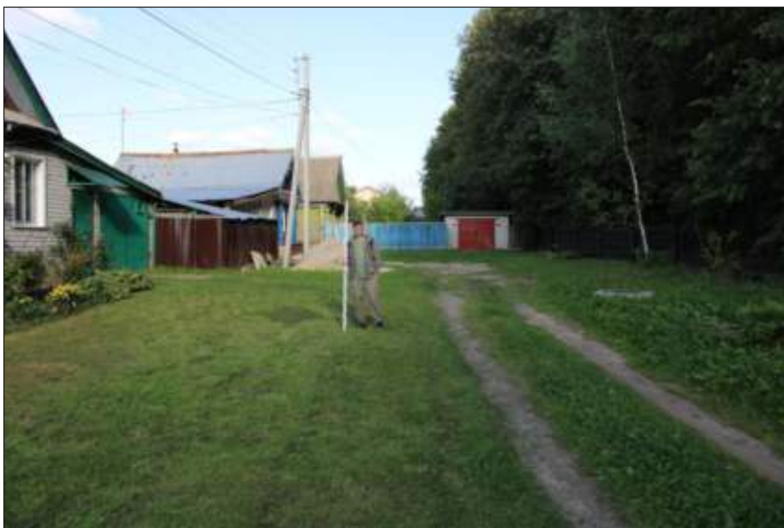
Илл. 24. Фотофиксация трассы проектируемого объекта «Газопровод-ввод к жилому дому по адресу: Нижегородская область, Городецкий район, г. Городец, ул. 9 Января, д. 21». Точка фотофиксации 3. Вид на участок трассы проектируемого газопровода, в пределах которого он будет прокладываться открытым способом (в траншее). Фото с ЗЮЗ
